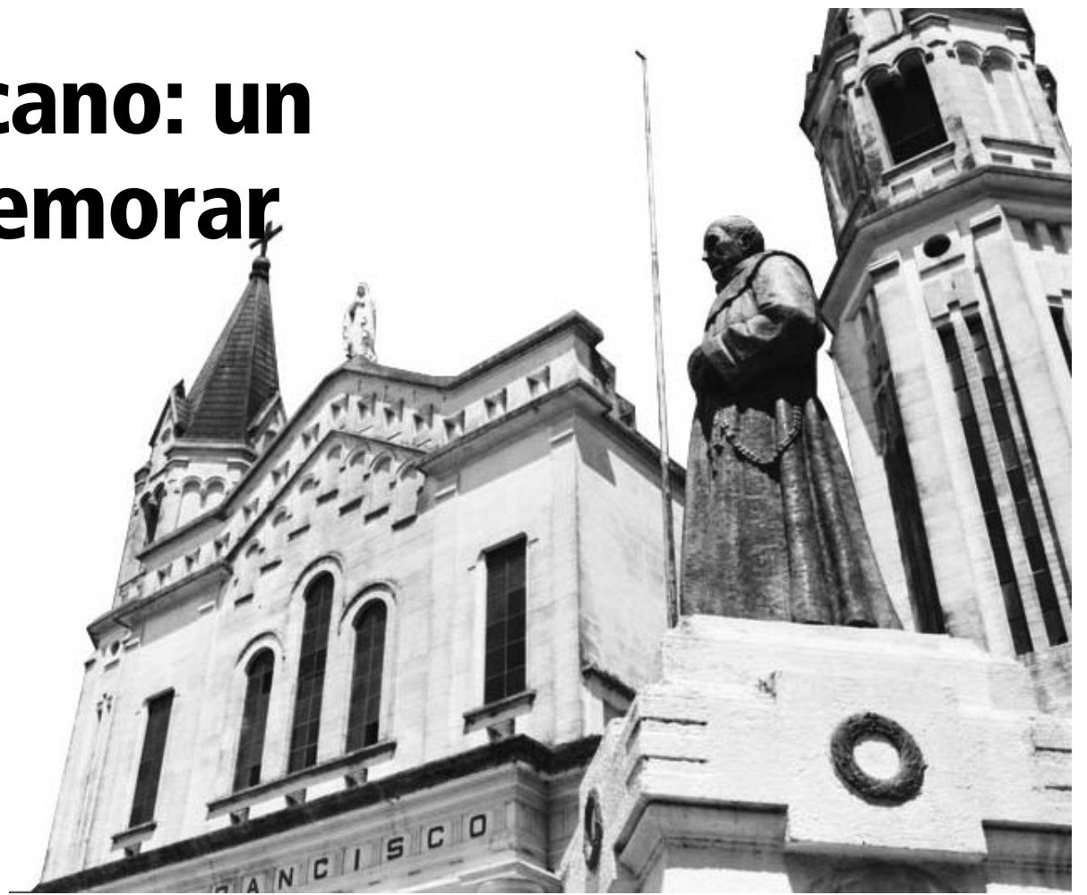
Edificio. Comenzó a funcionar en 1607. Hoy es una verdadera reliquia para los correntinos.
